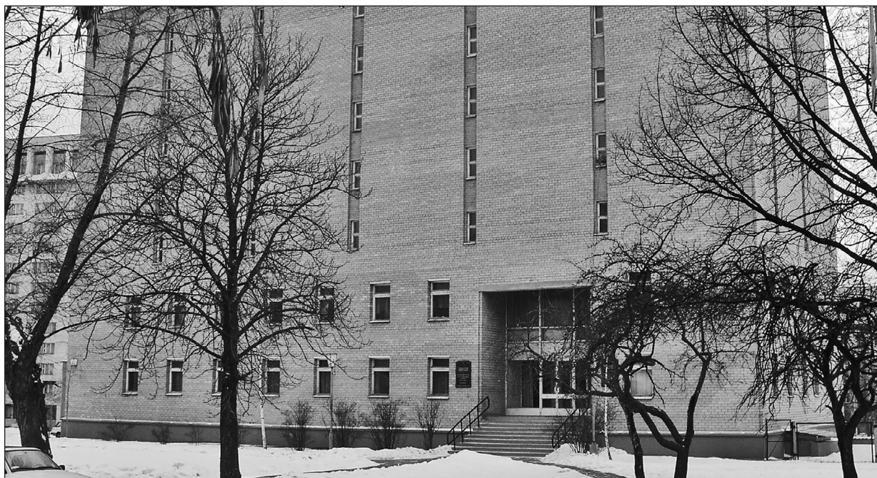
Ил. 7. Здание Национального исторического архива Беларуси по ул. Кропоткина, 55 в г. Минске, современный вид
